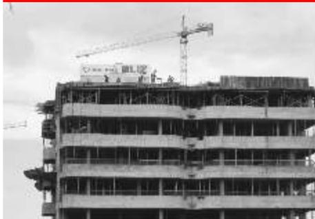
**A legislação diz que de três em três andares é obrigatório a colocação de paracordo e bandeja de proteção.**
